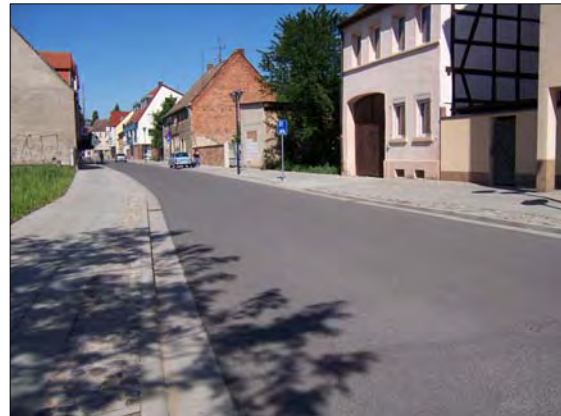
Die 2009 ausgebaute Steinstraße
