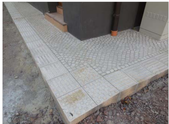
Baustellenfoto: taktiler Leitstreifen und Richtungsfeld, Stadt Schönebeck, 2015
