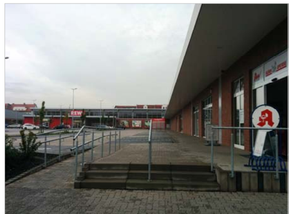
Barrierefreier Zugang Einkaufszentrum Schillerstraße, Stadt Schönebeck (Elbe), 2015
