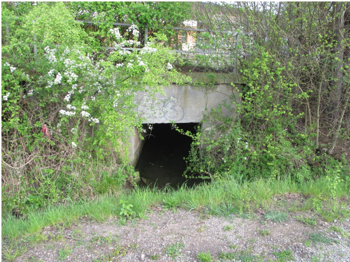
Abbildung 7-2: Anschlusspunkt 1 Unterführung Bahnhof Bad Salzelmen
