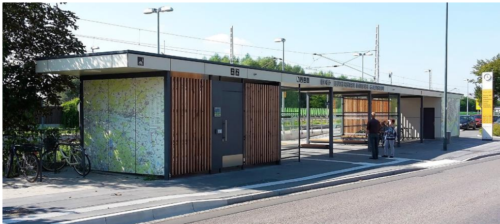
„Innostation“ Lutherstadt Wittenberg – Fertigstellung 2016
