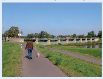
Einen Zwischenstopp am Pretziener Wehr (1871 bis 1875) sollten Sie auf jeden Fall mit einplanen. Mit einer Länge von 162,80 m und 324 Schützentafeln ist es das größte Schützentafelwehr Europas. Als ingenieurtechnische Höchstleistung seiner Zeit erhielt die Konstruktion im Jahr 1889 auf der Weltausstellung in Paris eine Goldmedaille. Noch heute ist es voll funktionsfähig und wird bei einem Elbpegel in Barby von 4,98 m gezogen.
