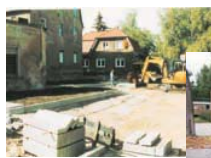
Platzgestaltung Querstraße vor dem Ausbau
