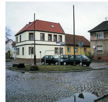
Gnadauer Straße vor dem Ausbau
