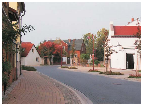
Gnadauer Straße nach dem Ausbau
