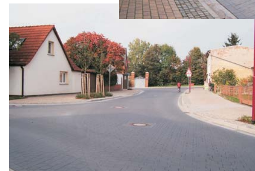
Gnadauer Straße nach dem Ausbau
