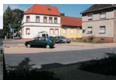
Nebenanlagen an der Straße Alt Felgeleben nach dem Ausbau
