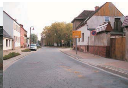
Gnadauer Straße nach dem Ausbau
