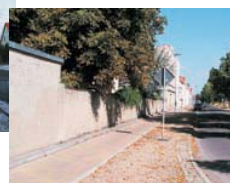
Gehweg an der Hermann-Kasten-Straße nach dem Ausbau,
