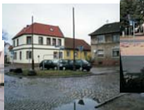
Nebenanlagen an der Straße Alt Felgeleben vor dem Ausbau
