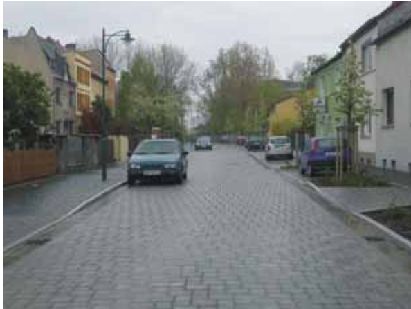
Der Friedhofsweg nach der Sanierung.
