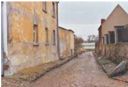
Der Hohlweg - Bestand 1999 ...
