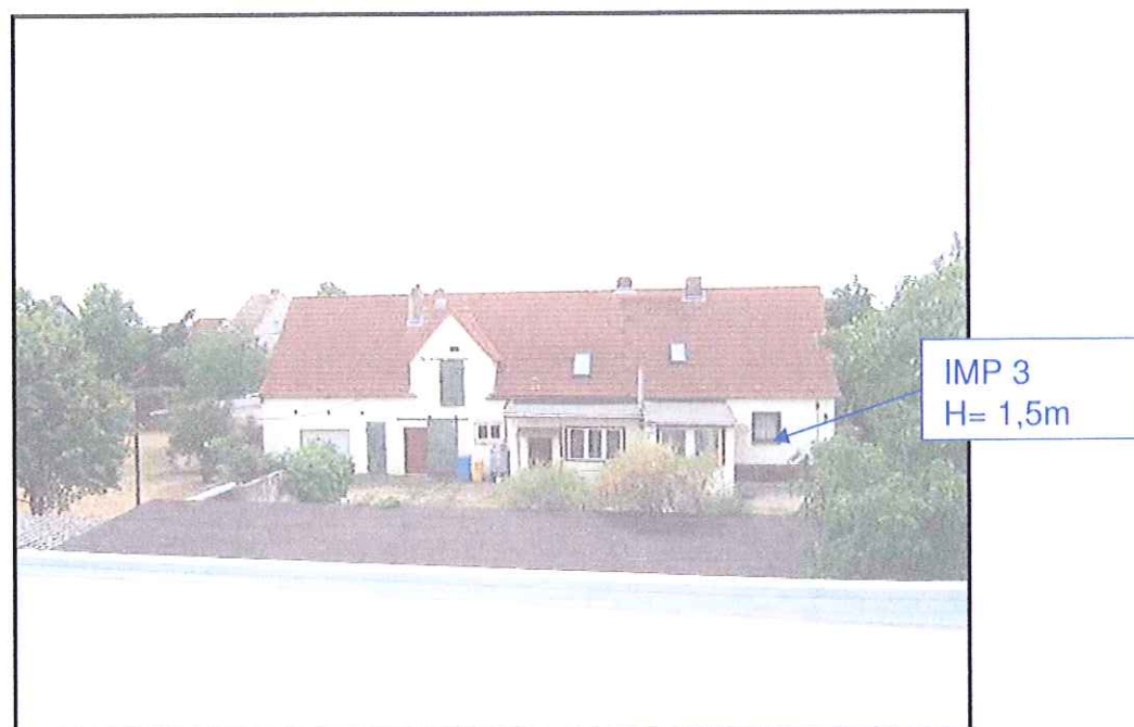
Bild 4: IMP 3, Wohnhaus Sachsenlandstraße 16
