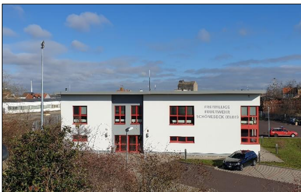
Foto 6: Das Dach des Gebäudes der FFW eignet sich für Photovoltaik (@Miehle)
