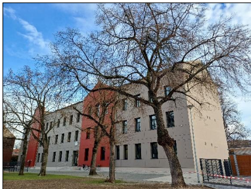
Foto 4: Die Käthe-Kollwitz-Schule nach der energetischen Sanierung, (©Miehle)
