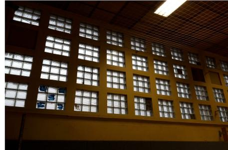
Zerstörte Fenster und Glasbausteine in Turnhalle, teilweise zerstört und provisorisch verschlossen
