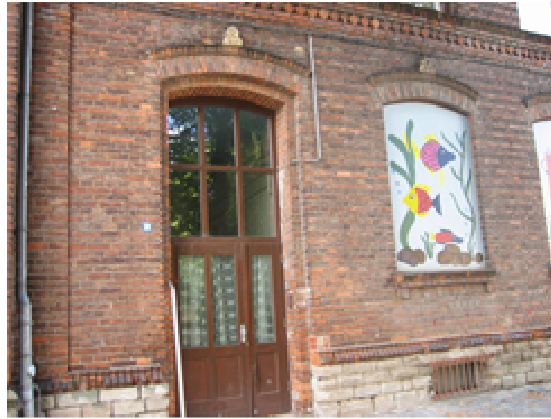
Schadhaftes Ziegelmauerwerk und Sockelbereich
