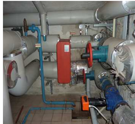
Verteilung der einzelnen Heizkreise mit Wärmemengenzählern und Effizienzpumpen
