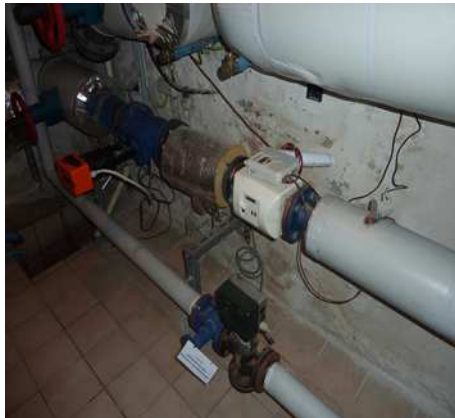
Verteilung der einzelnen Heizkreise mit Wärmemengenzählern und Effizienzpumpen
