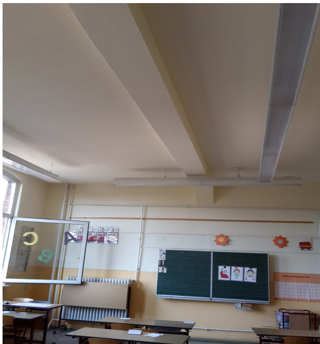
Beleuchtung der Klassenzimmer mit Leuchtstoffröhren
