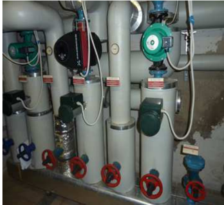
Verteilung der einzelnen Heizkreise mit Wärmemengenzählern und Effizienzpumpen
