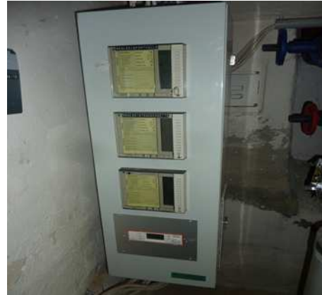
Verteilung der einzelnen Heizkreise mit Wärmemengenzählern und Effizienzpumpen
