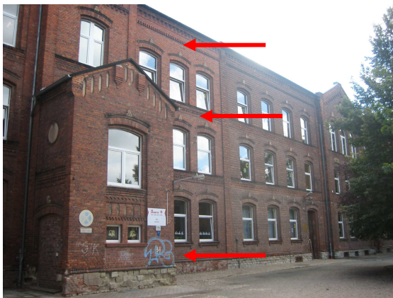
Wärmebrücken im Bereich Fassade Geschossübergänge
