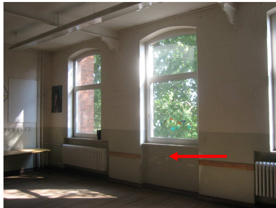
Wärmebrücken im Bereich Heizungs- und Fensterischen
