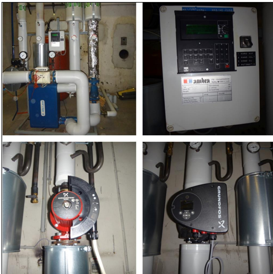
Abbildung 2: Fernwärmeübergabe-Station (320 kW)
