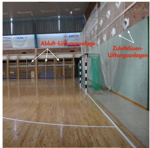
Lüftungsanlage
