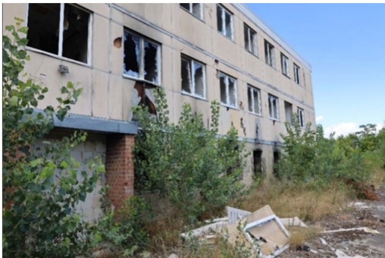
Starke Vermüllung und Verwahrlosung im Umfeld des Gebäudes 25
