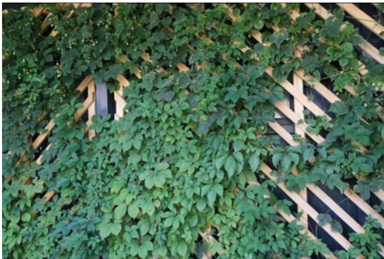
Beispielhafte bodengebundene Fassadenbegrünung mit Rankgerüsten 35
