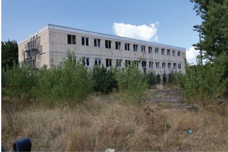
Ausprägung des verfallenen Zweckgebäudes im westlichen Teil des Geltungsbereiches 30
