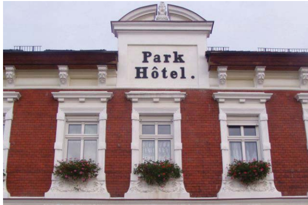
Das vorbildlich sanierte Park-Hotel, städtebaulich markant an der Ecke Immermann- / Magdeburger Straße gelegen, ist eines der prägendsten Gebäude im Kurbereich.
