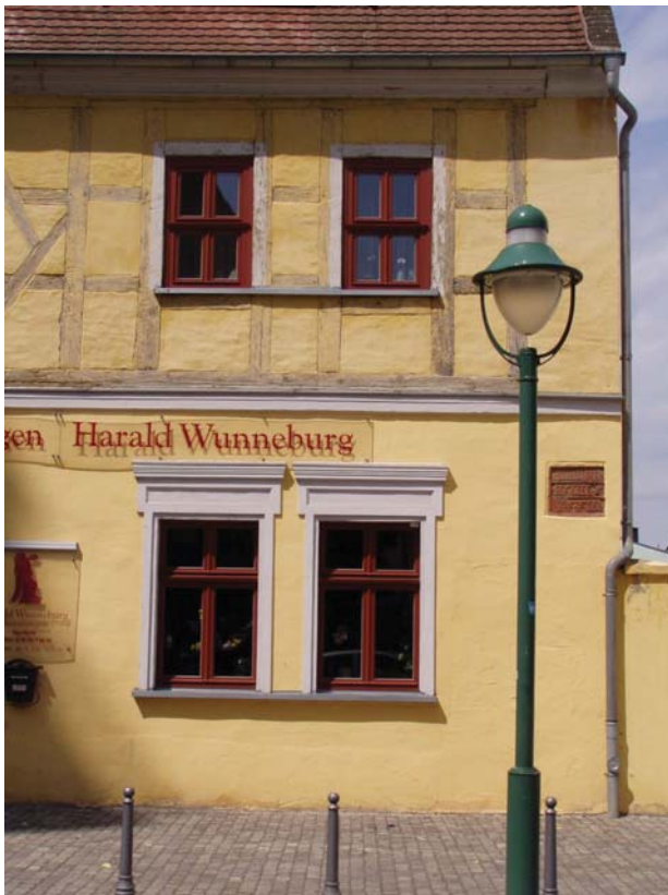
Am sogenannten Terminierhaus in der Kirchstraße 3, dem ältesten Haus in Bad Salzelmen, konnten das Fachwerk und spätmittelalterliche Mauerwerksstrukturen am Giebel freigelegt werden.
