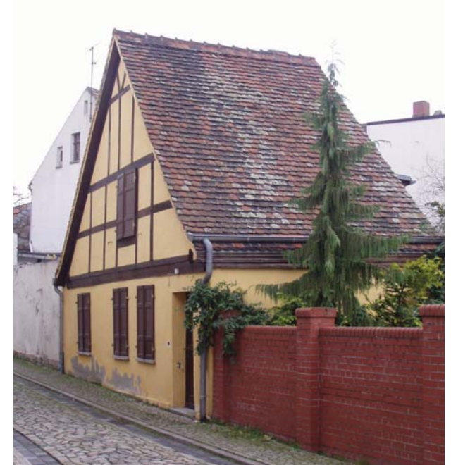
Salzsiede- oder Kothaus, Schneidewindstraße (vor/ nach Sanierung)
