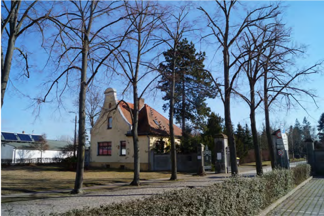
Ansicht aus Richtung Barbarastraße
